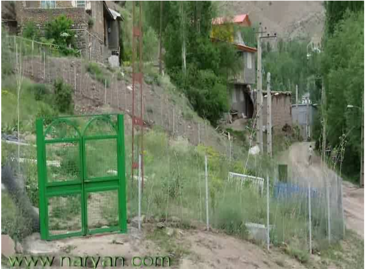
فنس کشی اطراف مزار که سمت غسلخانه کامل شده و درب ورودی کار گذاشته شده .
